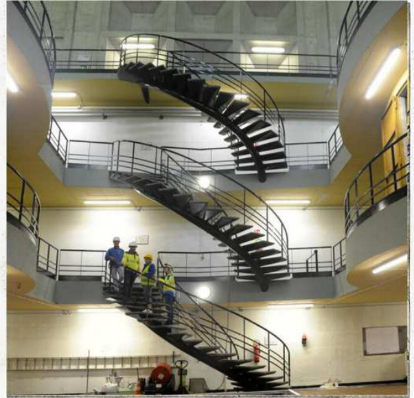
Le hall central de l'usine hydroélectrique de Saut-Mortier.
