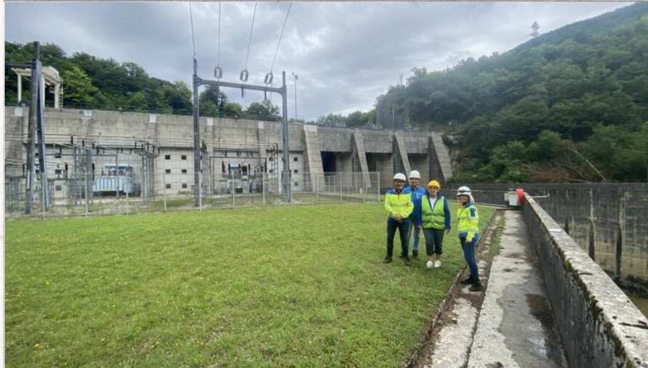
La turbine pompe qui remontera l'eau sera installée sur le côté du barrage usine de Saut-Mortier.
