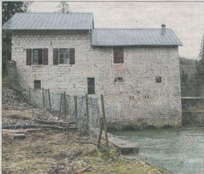
La centrale hydroélectrique de la Roche à Champagnole a été remise en service par la commune en 1981.
