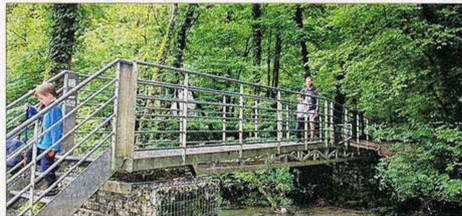
La passerelle restaurée franchit la Cuisance près de la centrale. Photo Progrès/Bernard GUILLOT
