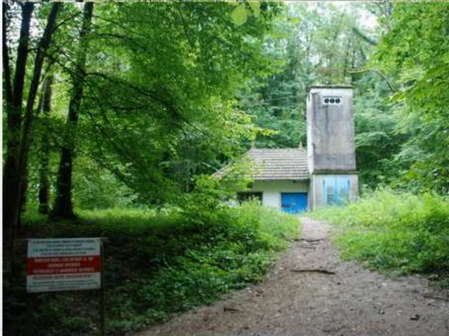
La microcentrale hydro-électrique est nichée au fond de la reculée. Photo Progrès/Bernard GUILLOT
