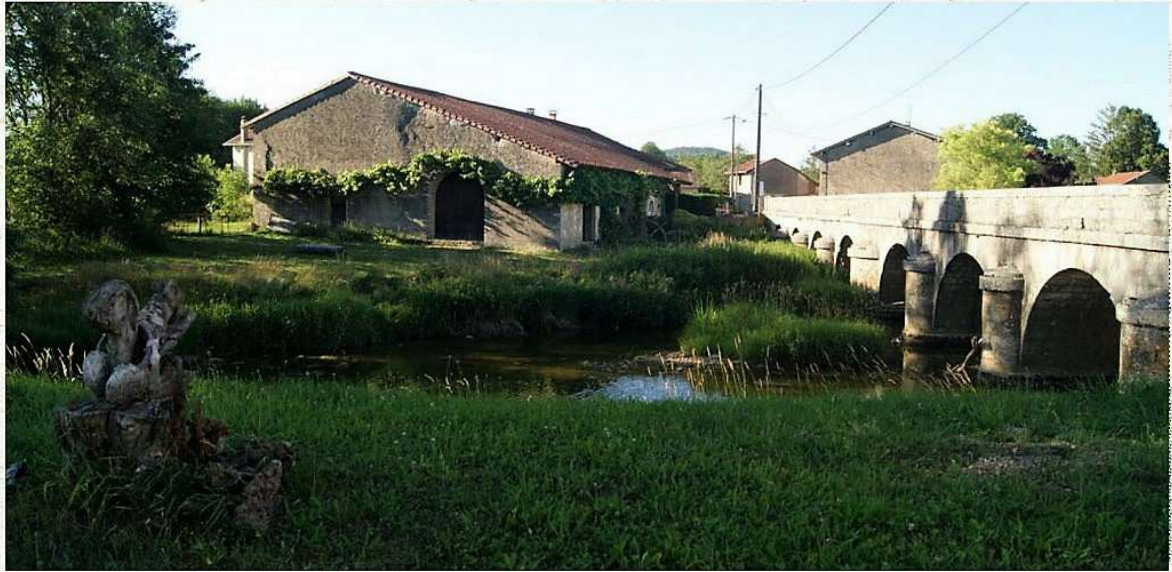
Le moulin du Pont des Vents à Montfleur. Photo Claude Roz
