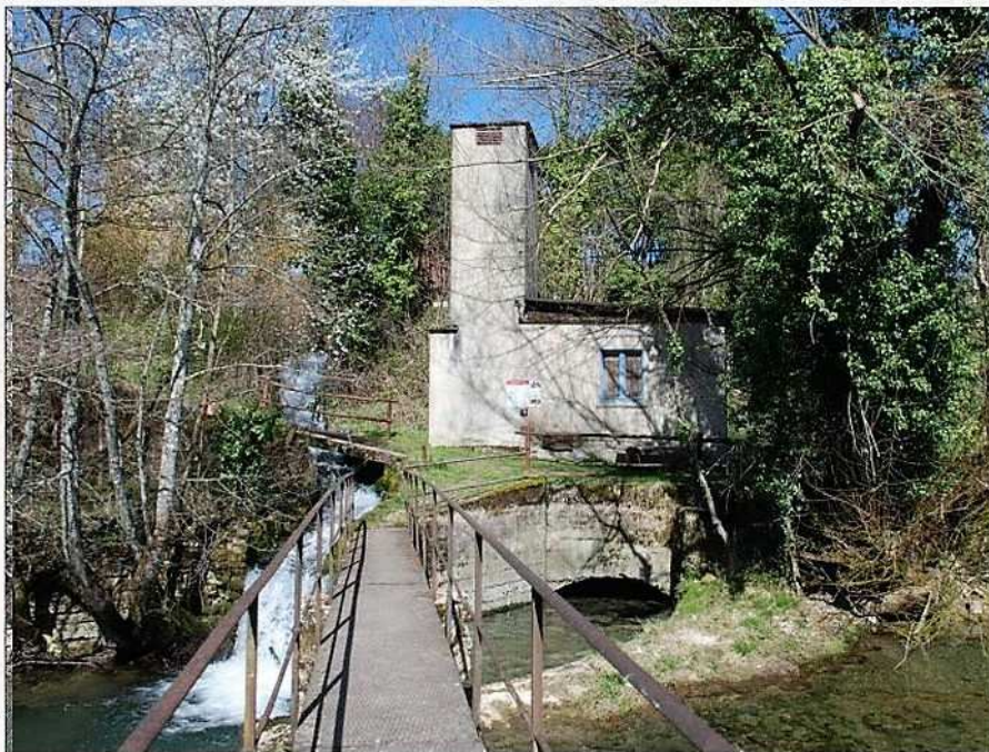
La turbine de la cartonnerie située à l'extérieur du bâtiment a été achetée par l'association La Cartonnerie de Mesnay en 2007. Photo Progrès/Bernard GUILLOT
